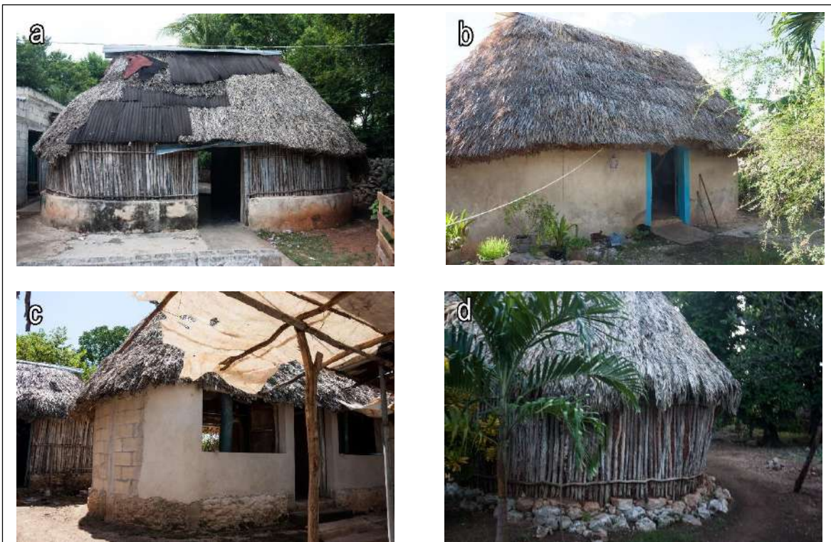
Figura 6. Tipos de zócalos o cimentaciones de la vivienda vernácula
