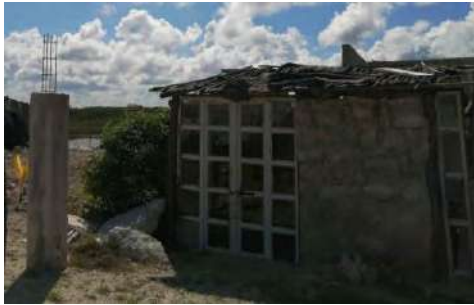
Figura 7. Casa en construcción (techo de lámina, con ladrillos en paredes, en ciénega de Chuburná Puerto.
