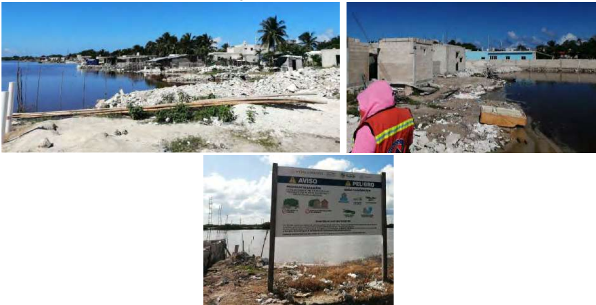
Figura 6. Casas en construcción, ciénega en occidente de Chicxulub Puerto. En la segunda fila, al centro, se observa el letrero de aviso de Zona Federal y riesgos asociados a vivir cerca de la ciénega, situado en la entrada del predio.
