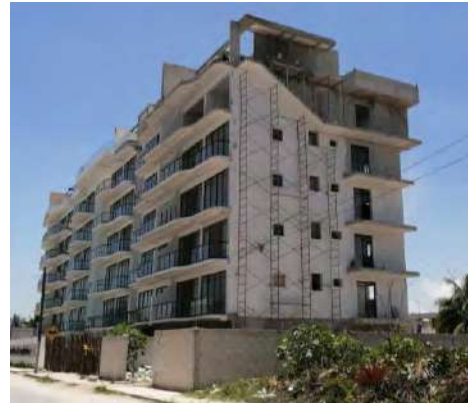
Figura 51. Condominios en construcción cerca del centro de Chicxulub Puerto, julio de 2022.
