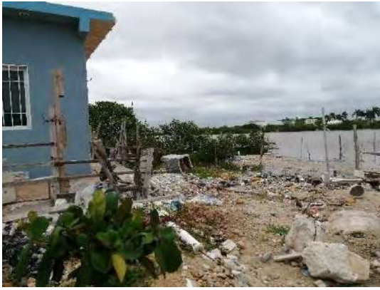
Figura 50. Casa aledaña a ciénega, con relleno reciente para ampliar su terreno. Progreso, enero de 2023
