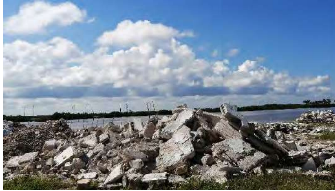
Figura 32. Relleno de ciénega con cascajo para construcción de vivienda, Chicxulub Puerto.
