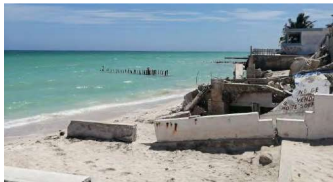
Figura 12. Escolleras y reducción de ancho de playa, Chuburná Puerto.
