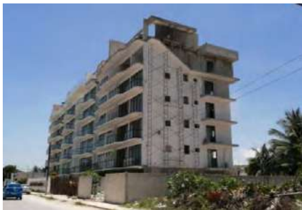
Figura 11. Construcción de edificio residencial, Chicxulub Puerto.
